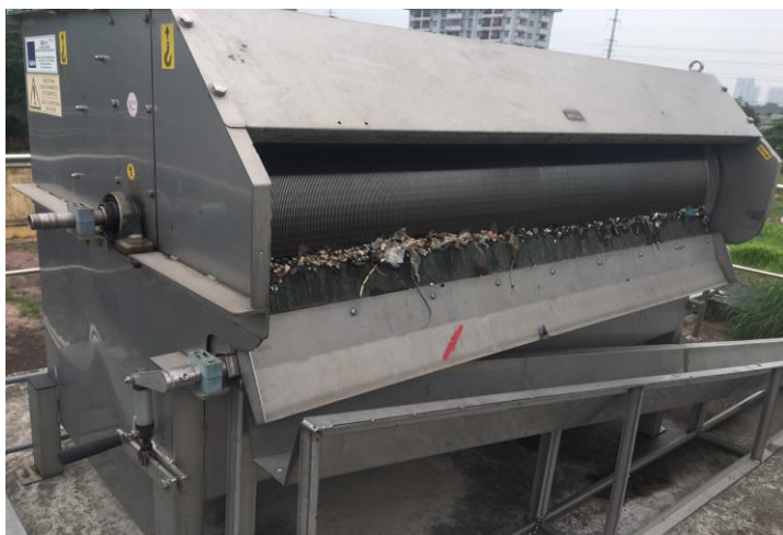
Hình 3.11: Hệ thống máy tách rác tinh FS201.1
