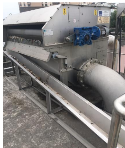
Hình 3.11: Hệ thống máy tách rác tinh FS201.1
