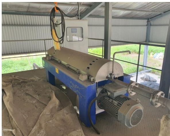
Hình 3.18: Máy ép bùn
